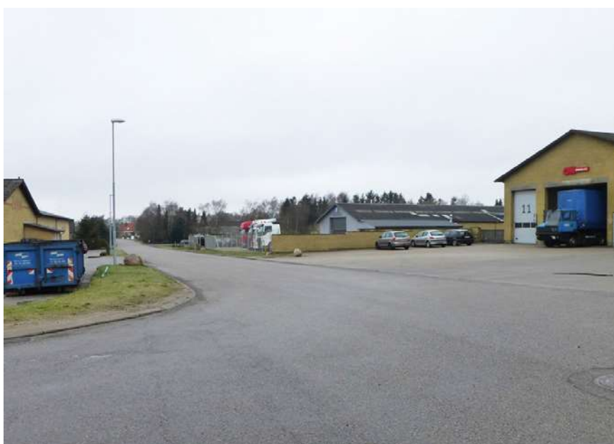
Holmevej i vestlig retning med lokalplanområdet på begge sider af vejen
